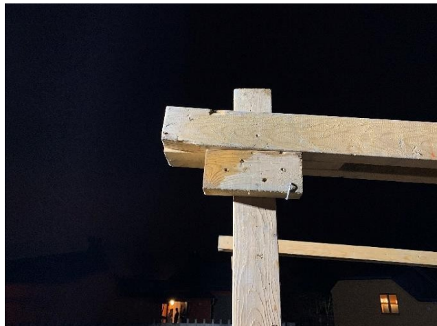
Takbalk på upplag.
