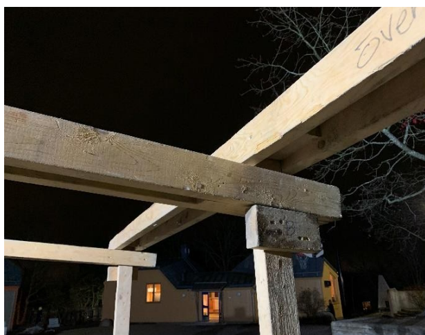
Överliggare på takbalk på mittstolpen.
