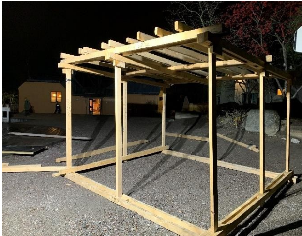
Takbalkar, överliggare och sparrar högst upp.
